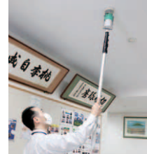
熱用・煙用感知器の点検
